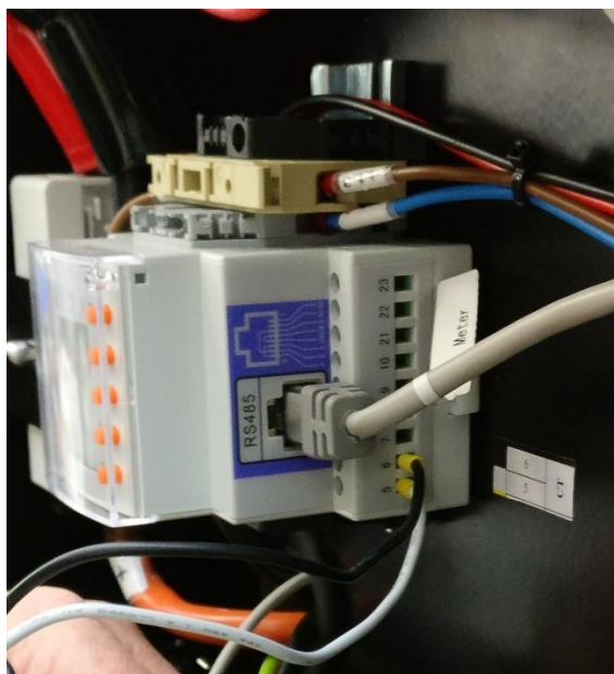
Figura 45 – Collegamento dei 2 cavi del sensore CT sul Meter Acrel
