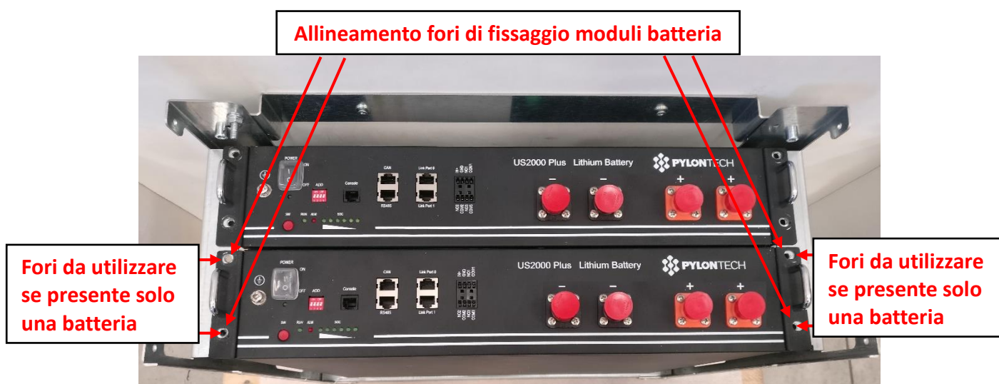
Figura 8 - Alloggiamento moduli batteria (se pervisti 2 moduli dalla dotazione)
